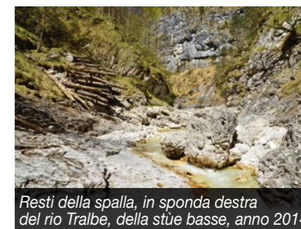
Spalla destra della Stùe basse di Tralbe - Resti dell'incastellatura modulare ( cassice ) con la zavorra di pietre, anno 2014.
